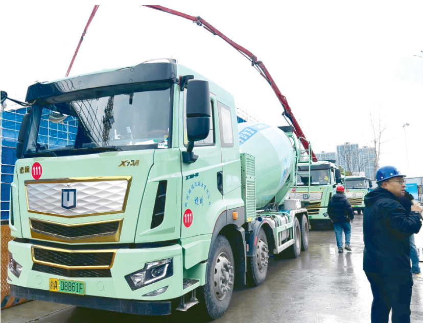
远程X7M醇氢电动搅拌车正在工地上作业。
