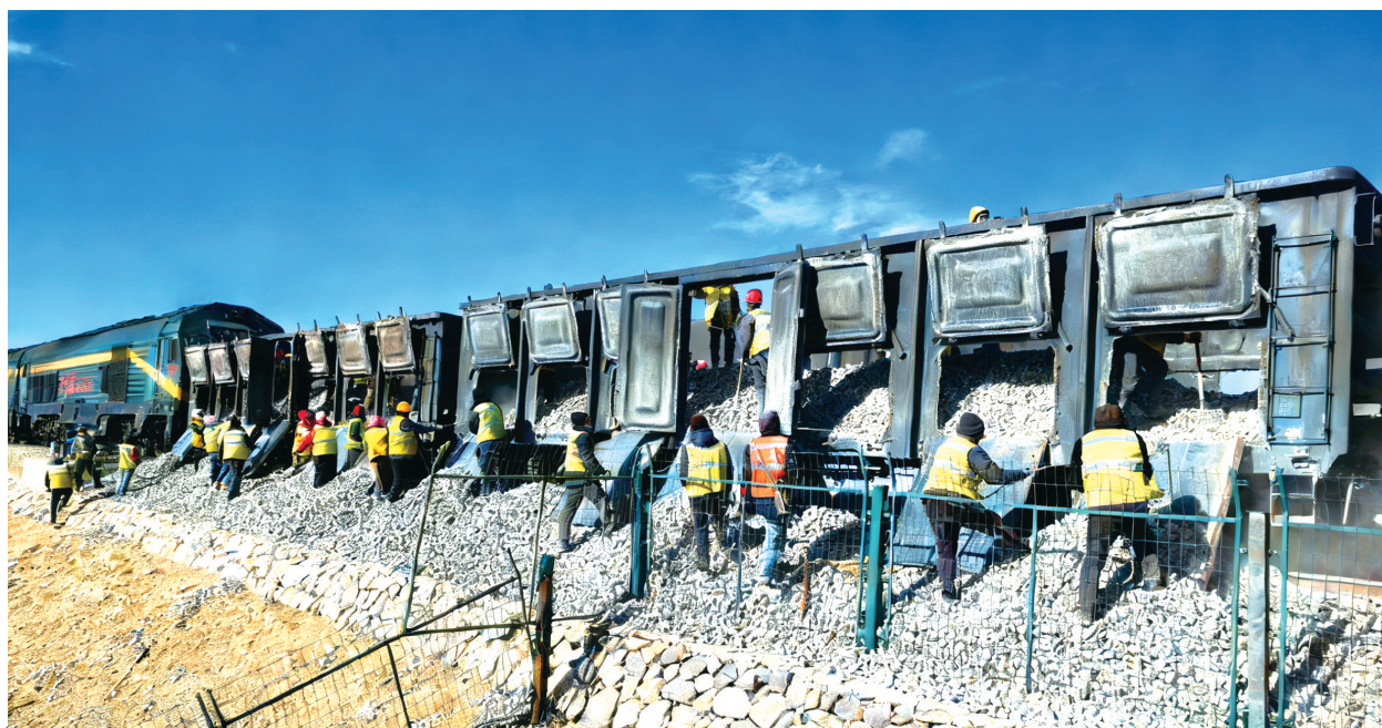
春节期间，在中铁十二局养护公司青藏铁路格拉段养护段，气温零下20至30摄氏度，管段100余名管理人员、近200名作业工人在全线数十个作业点进行养护作业，保障春运安全。图为那曲线路车间工人在卸道渣。（赵桂军 摄）
