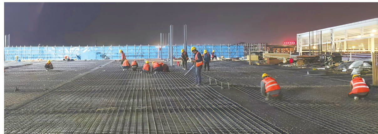
工人正在邻近营业线绑扎钢筋。(刘建军 摄)
